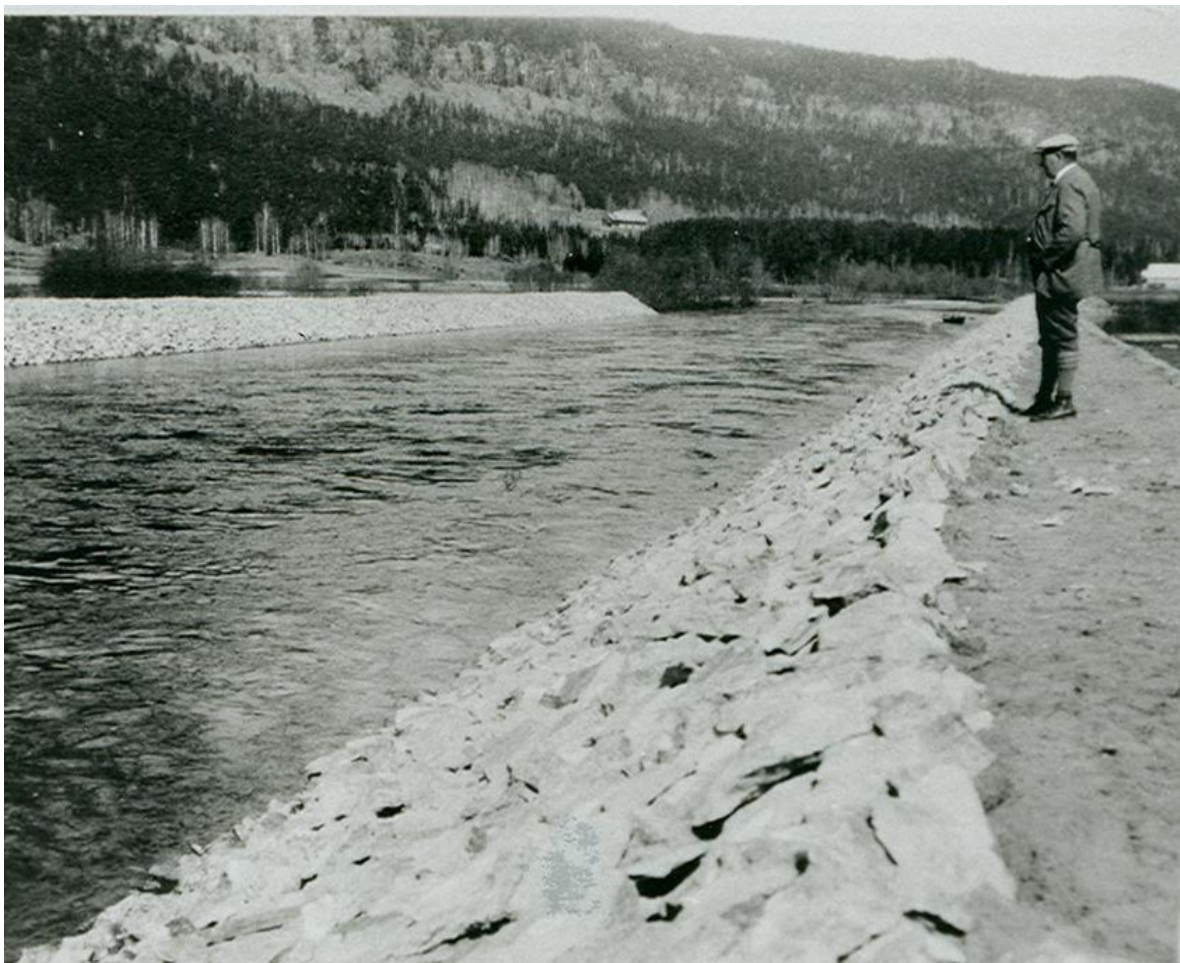
Figur 7. Kanalisering av Etna ved Ulvshus på Nordsinni. Gammelt foto utlånt av Randsfjordmuseene. Bildet er tatt ca. 1930
